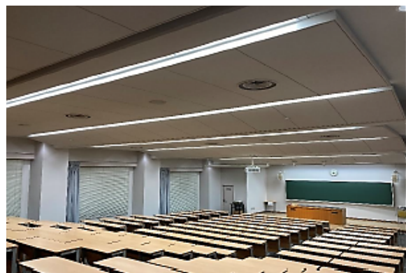
教育 1 号館講義室 LED 化工事
