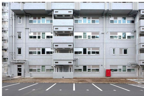
研究 1・2 号館改修工事
