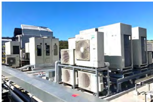
研究1・2号館改修工事
